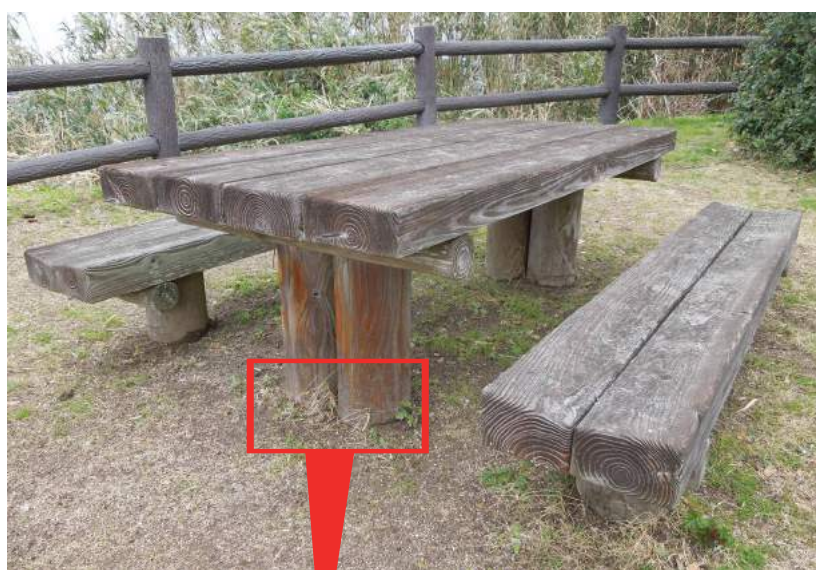
ベンチの地際（施工後 13 年目撮影）
